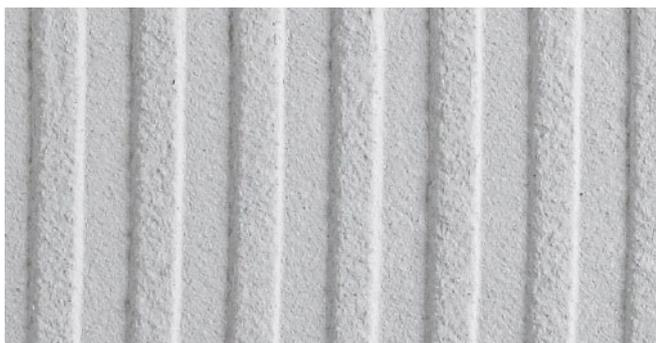
AUS Modellierputz (структурирование штукатурки зубчатой кельмой)
