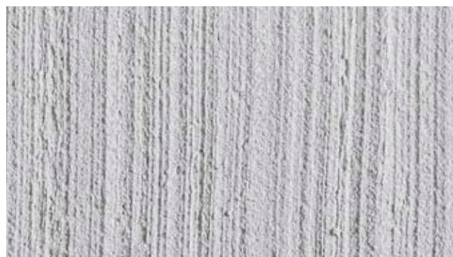
AUS Modellierputz (superfície modificada com escova)
